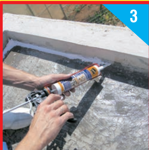
Ακρυλικός Στόκος - Σφράγιση ρωγμών
