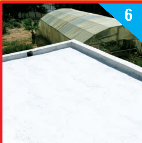
Αποτέλεσμα Τελικής Στρώσης
